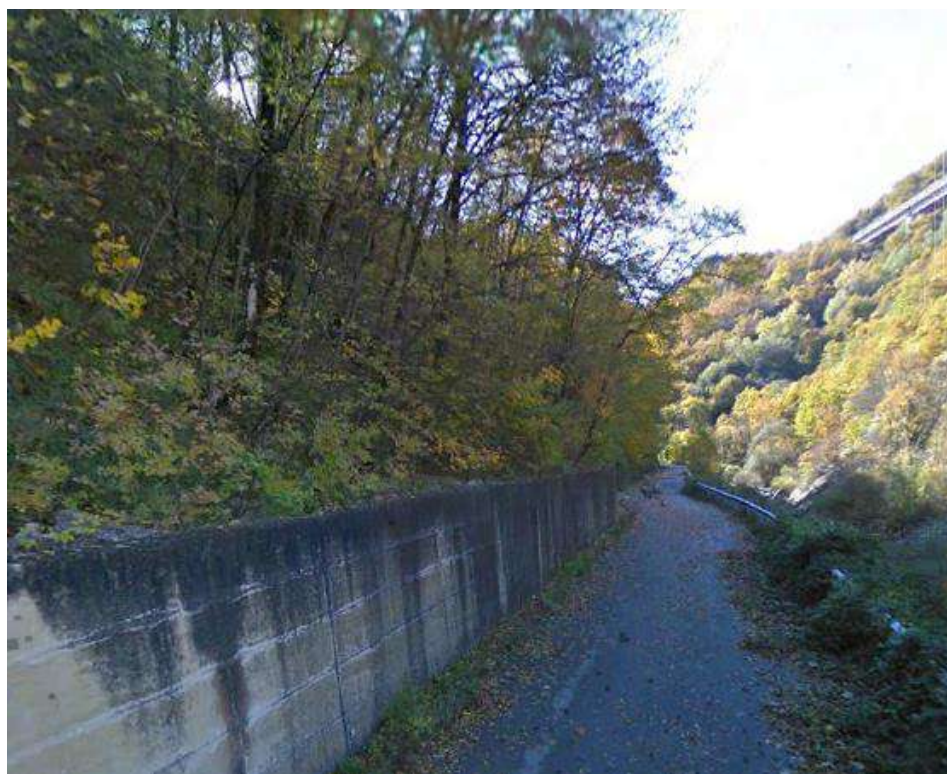
Fig.9: Rilevamento geomorfologico – Frana 1 . Oltre alle buone condizioni del manto stradale, anche il muro di contenimento non mostra evidenze di deformazioni - Punto di vista fotografico b
