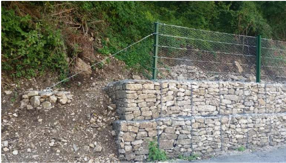
Fig.21: Tav.4 Opere di stabilizzazione in corso di ultimazione lungo il percorso del cavidotto interrato
